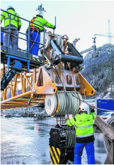
Abbildung 3: Das Seil ist nicht aus Stahl, sondern aus Kunststofffasern.
